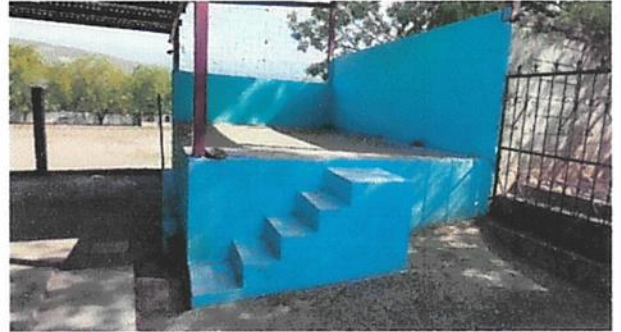
INSTALACION DE BARANDA DE SEGURIDAD EN ESCENARIO
