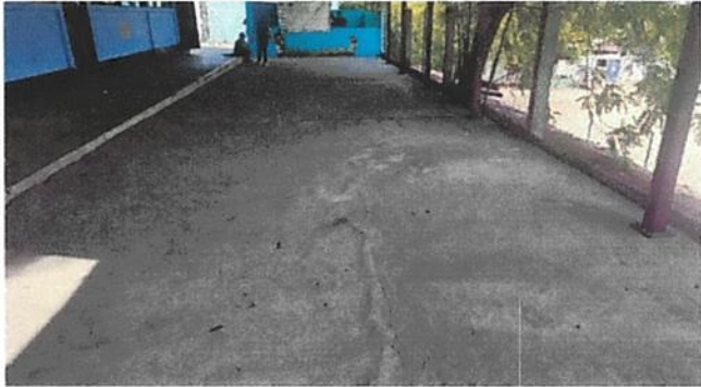
SUSTITUCION DE LOSA DE CONCRETO DE 0.08 CMS
