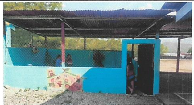
SUSTITUCION DE LAMINA POR LAMINATROQUELADA ALUZIN C.26
