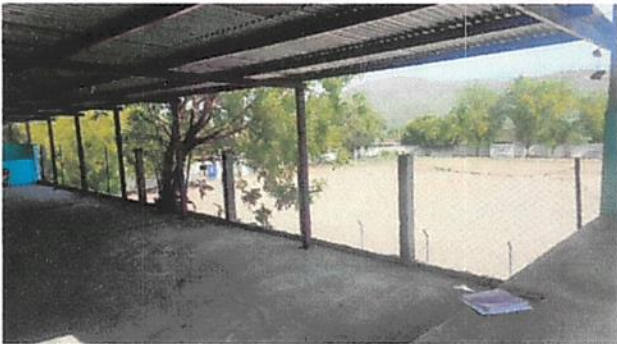
SUSTITUCION DE MALLA
