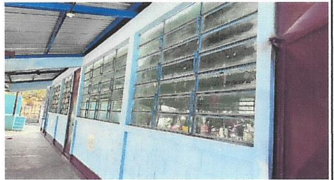
SUSTITUCION DE VIDRIOS
