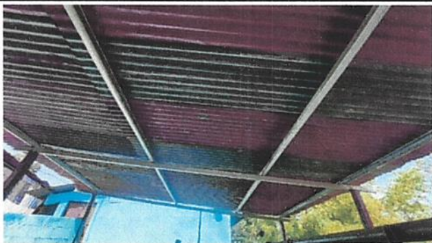
SUSTITUCION DE LAMINA POR LAMINATROQUELADA ALUZIN C.26
